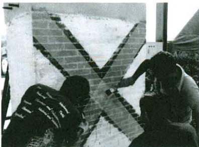
รูปที่ 9 การติดตั้งแผ่น FRP
