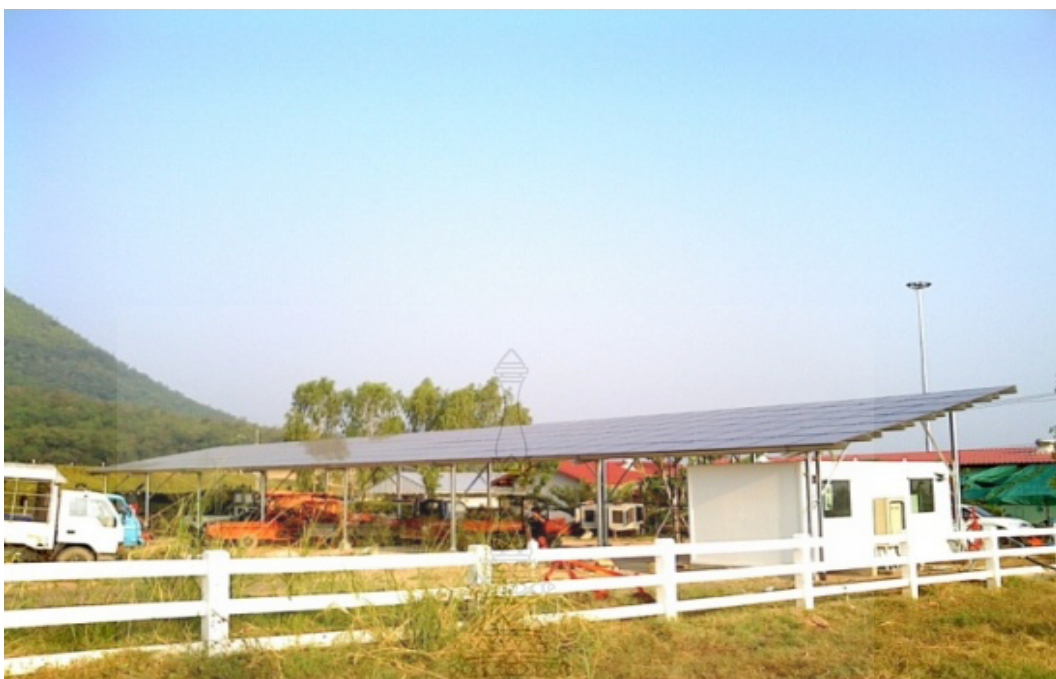
ภาพที่ 4.1 ระบบที่ใช้ทดสอบโปรแกรม ณ อำเภอยาง จังหวัดเพชรบุรี ขนาด 25 กิโลวัตต์สูงสุด
