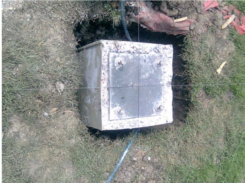
รูปที่ 3.15 ฐานรากเสารองรับ โครงสร้างแผงเซลล์แสงอาทิตย์
