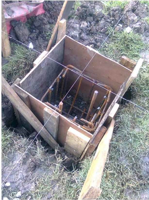
รูปที่ 3.14 การเตรียมเทฐานรากรองรับโครงสร้างแผงเซลล์แสงอาทิตย์
