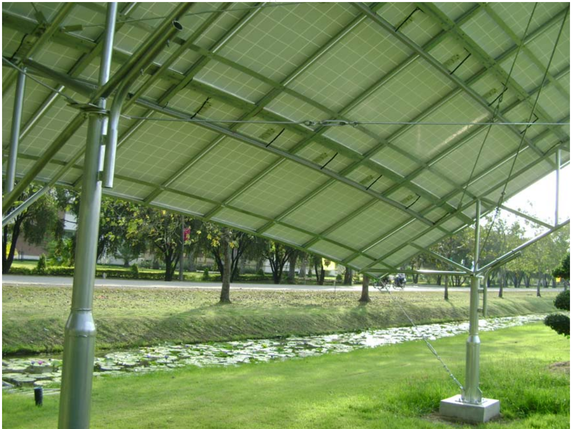
รูปที่ 3.19 โครงสร้างรองรับแผงเซลล์แสงอาทิตย์ มหาวิทยาลัยเทคโนโลยีราชมงคลธัญบุรี
