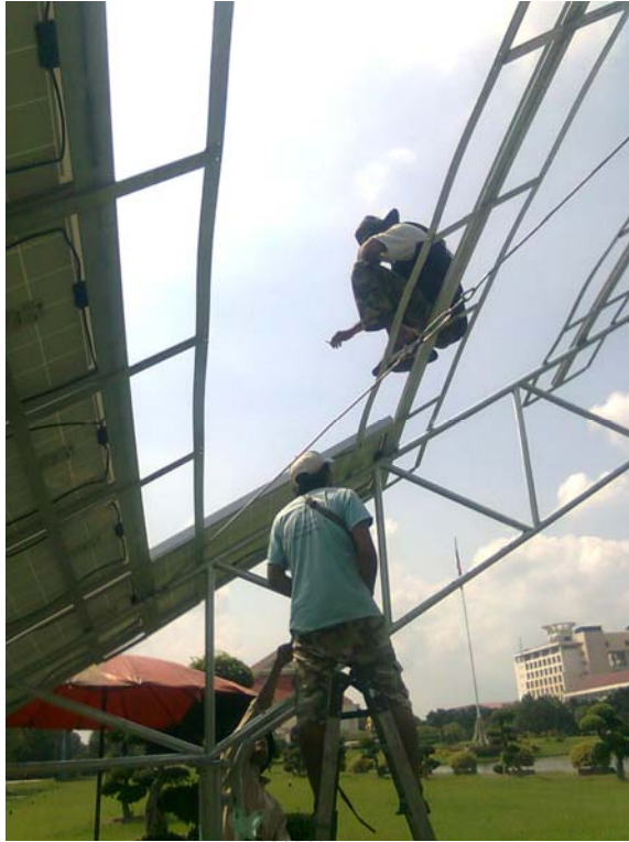
รูปที่ 3.17 การติดตั้งแผงเซลล์แสงอาทิตย์
