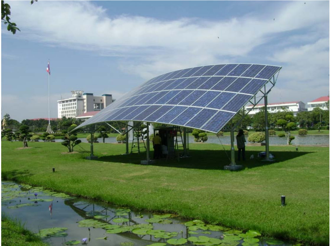
รูปที่ 3.20 การติดตั้งแผงเซลล์แสงอาทิตย์แล้วเสร็จ
