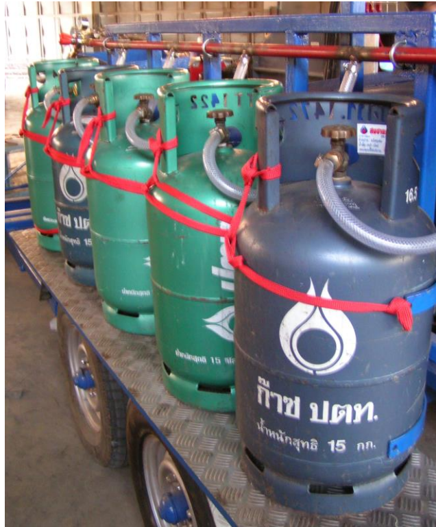
ภาพที่ 4.5 ลักษณะการติดตั้งถังแก๊ส แอล พี จี
