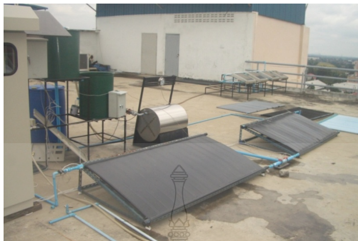
ภาพที่ 3.5 การติดตั้งการทดลองแผงผลิตน้ำร้อนจากพลังงานแสงอาทิตย์
