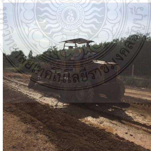
รูปที่ 3.15 แสดงการดำเนินการผสมเปียกดินกับซีเมนต์ในแปลงทดสอบ
