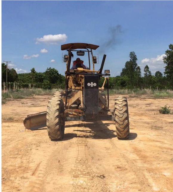
รูปที่ 3.10 แสดงการดำเนินการเคลียร์พื้นที่ก่อนก่อสร้างแปลงทดสอบ
