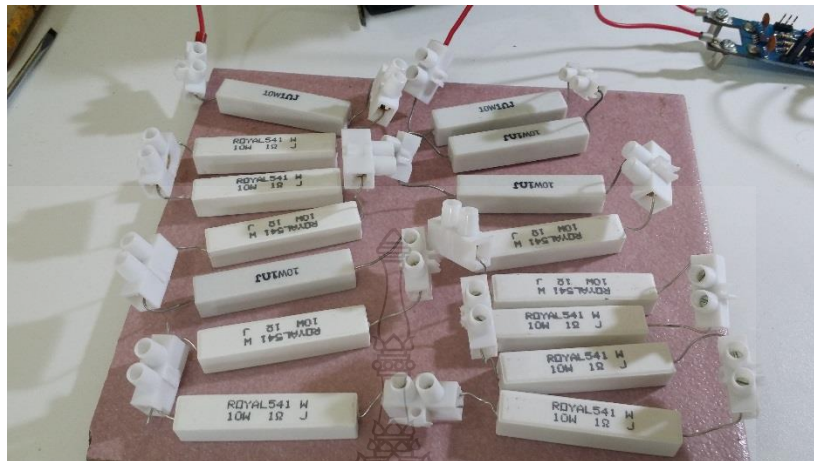
รูปที่ 3.32 โหลดแบบความต้านทาน (R) ที่ใช้ในการทดสอบวงจรในงานวิจัย
