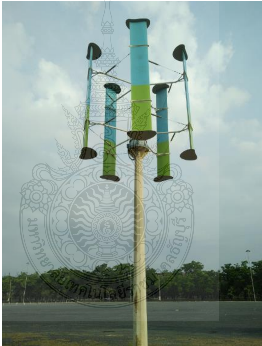
รูปที่ 3.1 กังหันลมผลิตไฟฟ้าแบบแกนตั้งชนิด 5 ใบขนาด 3 กิโลวัตต์
