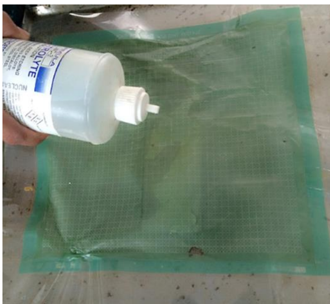
รูปที่ 3.12 การเทกรดลงบนแผ่นฟิล์มและเหล็ก
