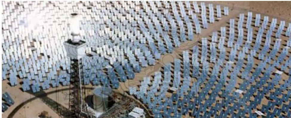
รูปที่ 2.19 แสดงภาพโรงไฟฟ้า Solar One
