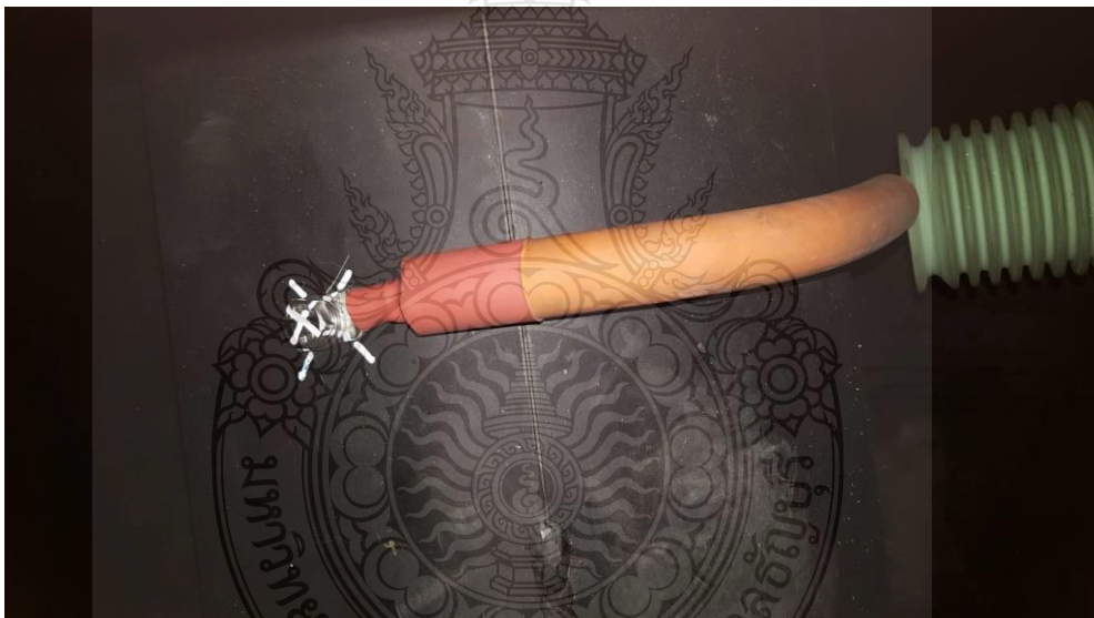
รูปที่ 4.16 การแก้ไขหลังจากตรวจพบสาเหตุที่สตริมเทอร์มินัล 10 เฟส A
