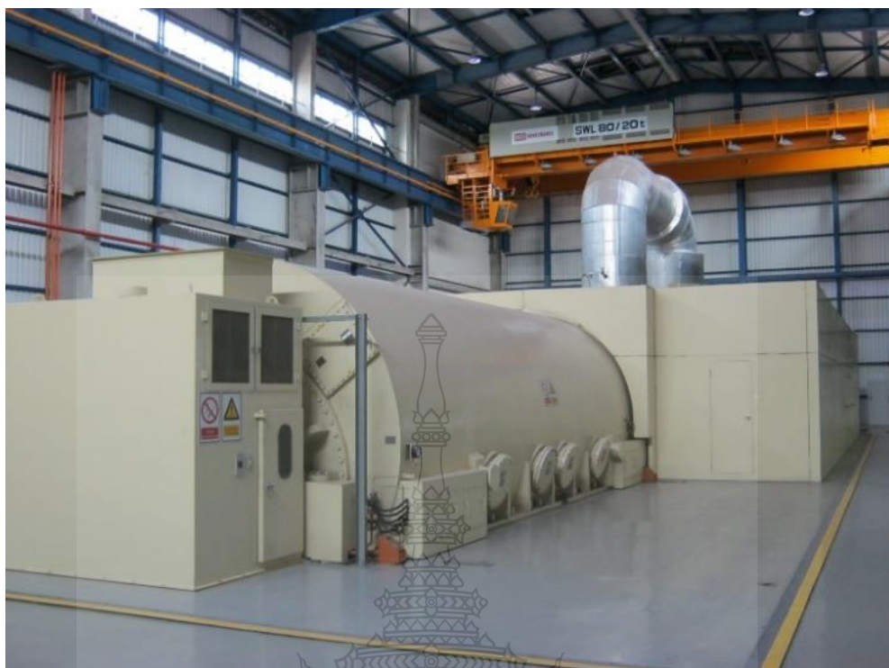
รูปที่ 3.6 สตริมเทอร์ไบน์ มีอยู่ทั้งหมด 2 หน่วย
