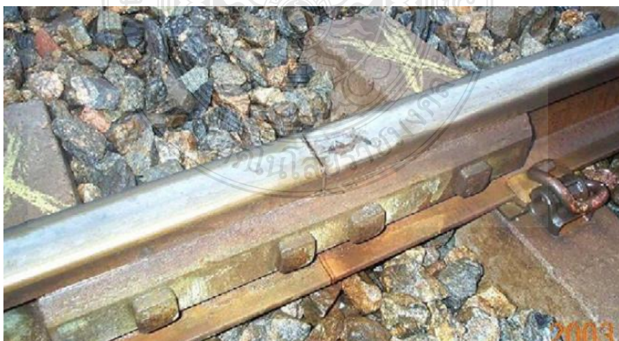
รูปที่ 2.41 ความผิดปกติของรางระหว่างรอยต่อ
