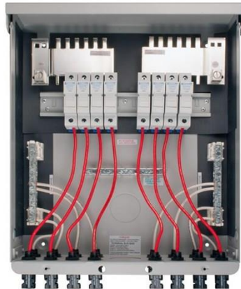
รูปที่ 2.17 กล่องต่อรวมสาย (Combiner Box) [24]
