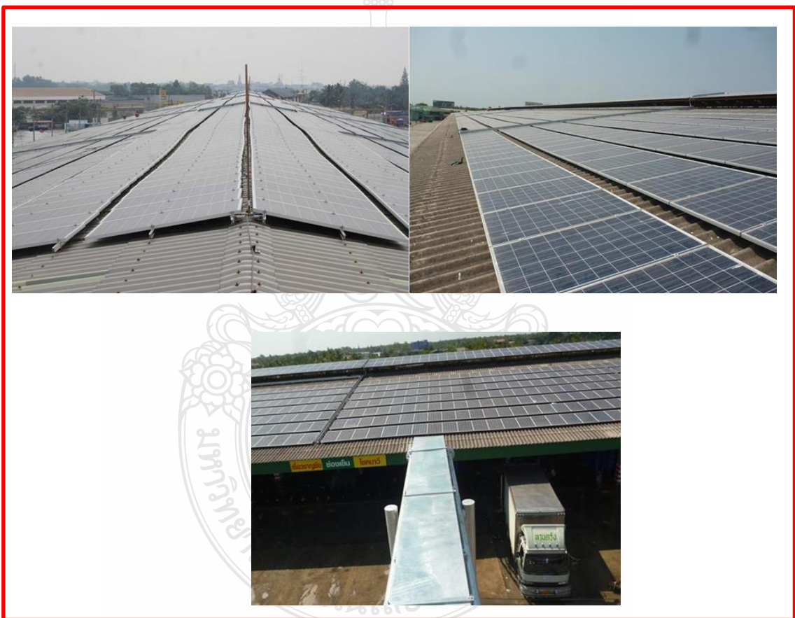
รูปที่ 3.1 สถานที่ติดตั้งโรงไฟฟ้าพลังงานแสงอาทิตย์แบบติดตั้งบนหลังคาพิกัดขนาด 1 MW
