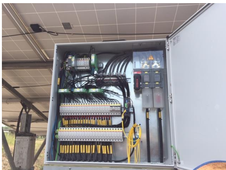
รูปที่ 3.12 กล่องต่อรวมสาย (Combiner Box)
