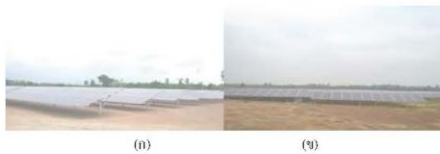
รูปที่ 2 การติดตั้งแผงเซลล์แสงอาทิตย์ (ก) ชนิดฟิล์มบาง (ข) ชนิดผลึกรวมซิลิคอน
