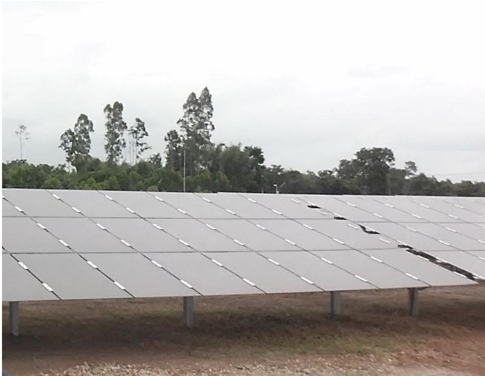
รูปที่ 3.3 ลักษณะการติดตั้งแผงเซลล์แสงอาทิตย์ ชนิดฟิล์มบาง
