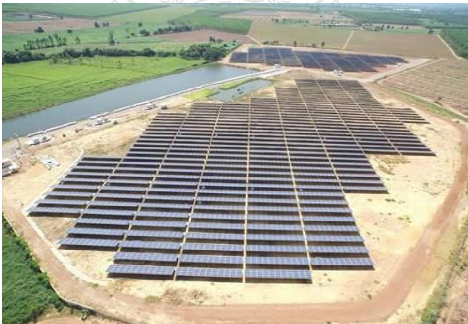
รูปที่ 3.4 โรงไฟฟ้าพลังงานแสงอาทิตย์ ชนิดผลึกรวมซิลิคอน
