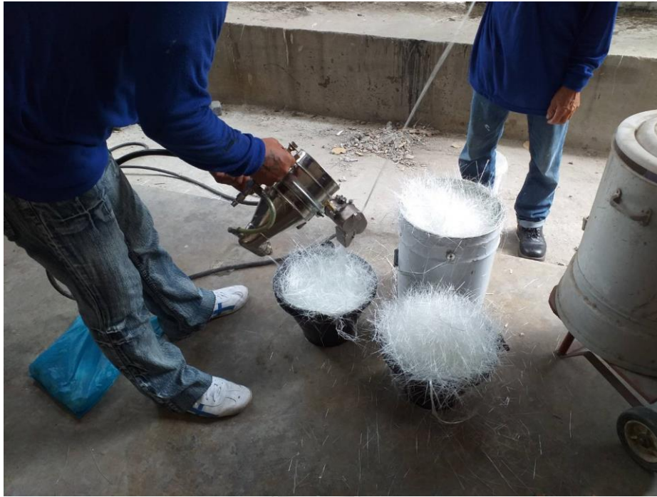
รูปที่ 3.15 การติดตั้งพอลิเมอร์เสริมเส้นใยแก้วระบบพ่น
