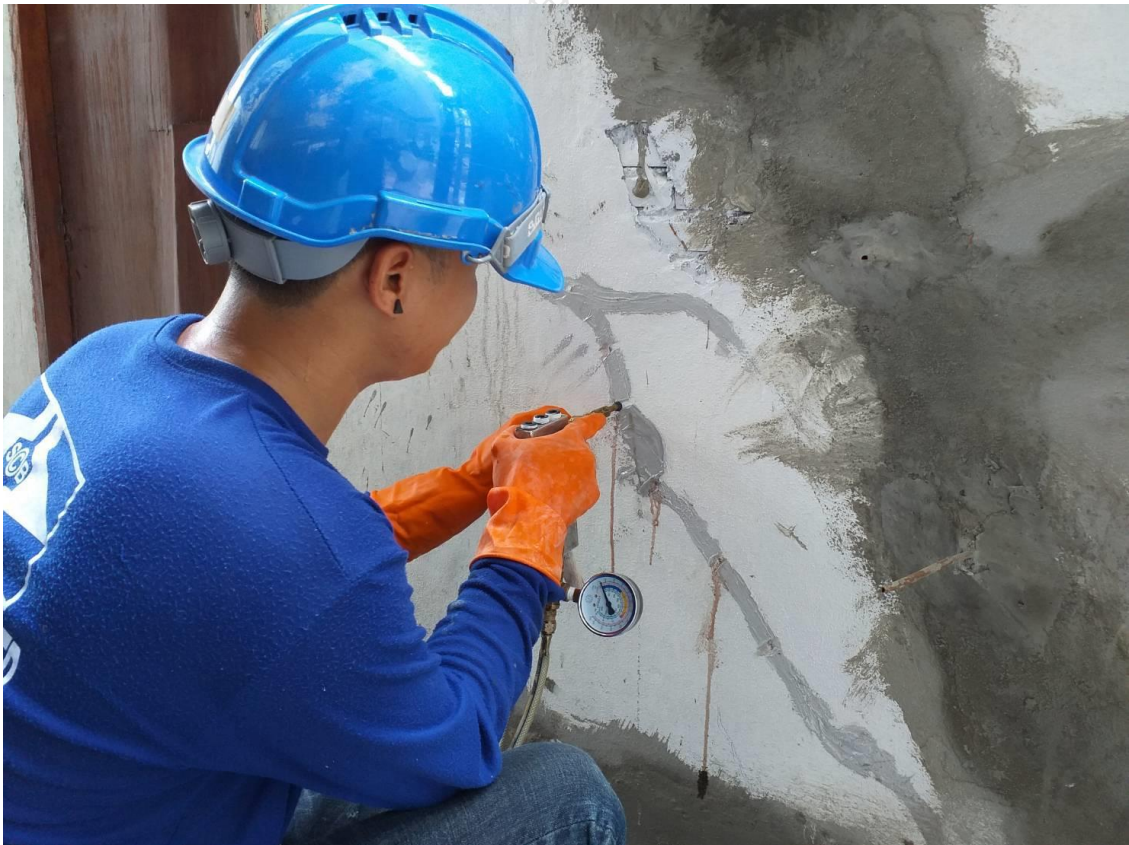
รูปที่ 3.12 การซ่อมแซมผนังอิฐก่อโดยอัดฉีดอีพ็อกซีเรซินหลังจากการวิบัติ
