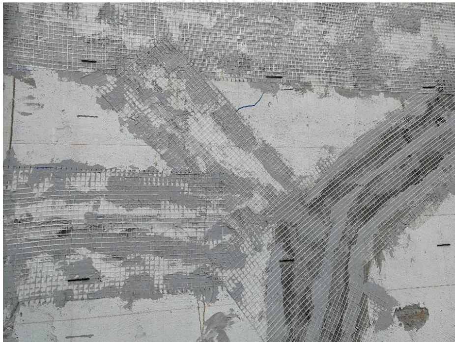
รูปที่ 3.14 การยึดรอยแยกของผนังอิฐก่อด้วยตาข่ายประเภทเส้นใยแก้ว
