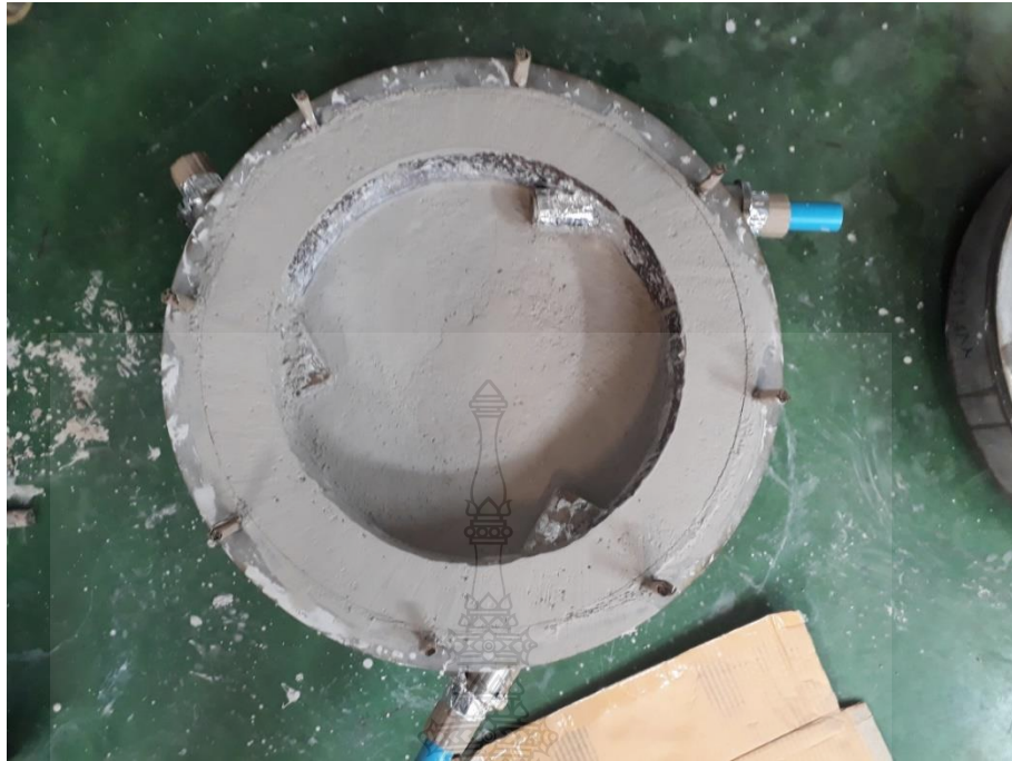
รูปที่ ค.5 การเทคอนกรีตทนไฟภายในห้องเผาไหม้
