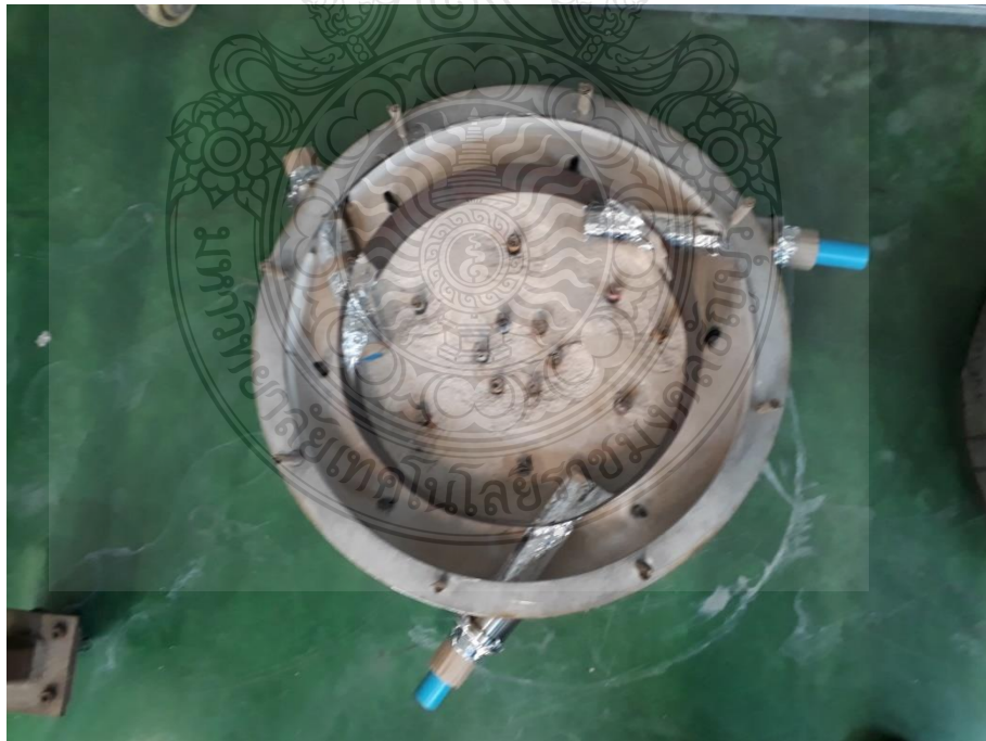
รูปที่ ค.4 การวางแบบหล่อคอนกรีตทนไฟ
