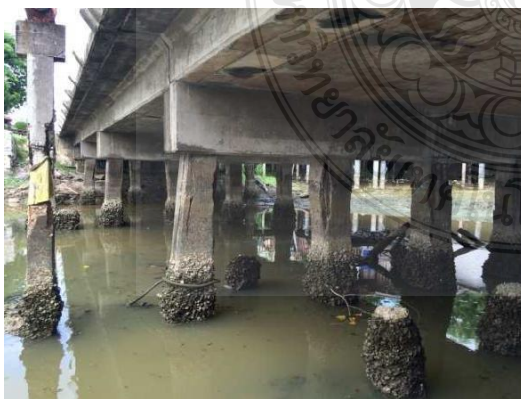
รูปที่ 2.2 ตัวอย่างความเสียหายเนื่องจากการเกิดสนิมของเหล็กเสริมในคอนกรีตเนื่องจากเกลือคลอไรด์
