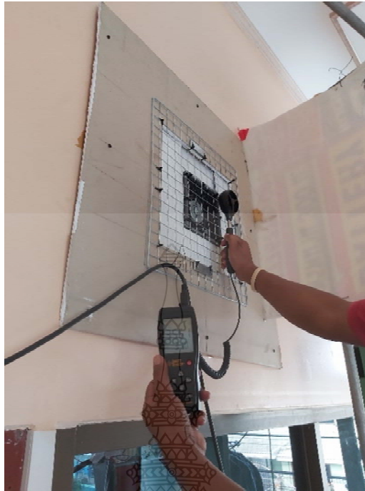
รูปที่ 4.9 แสดงการวัดค่าอัตราการระบายอากาศ
