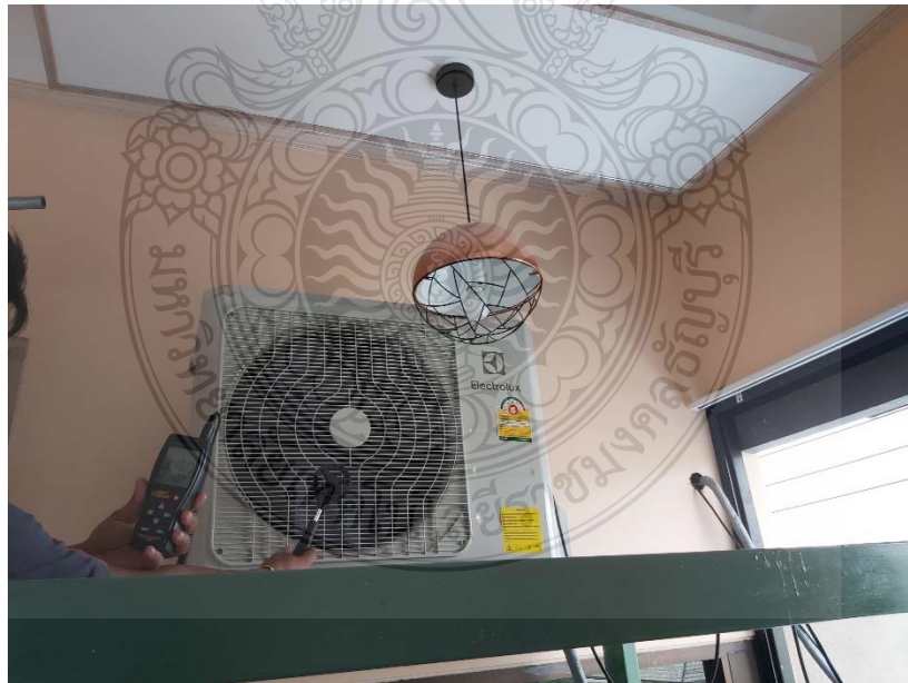
รูปที่ ก.4 เครื่องควบแน่นของเครื่องปรับอากาศขนาด 18,700 Btu/hr
