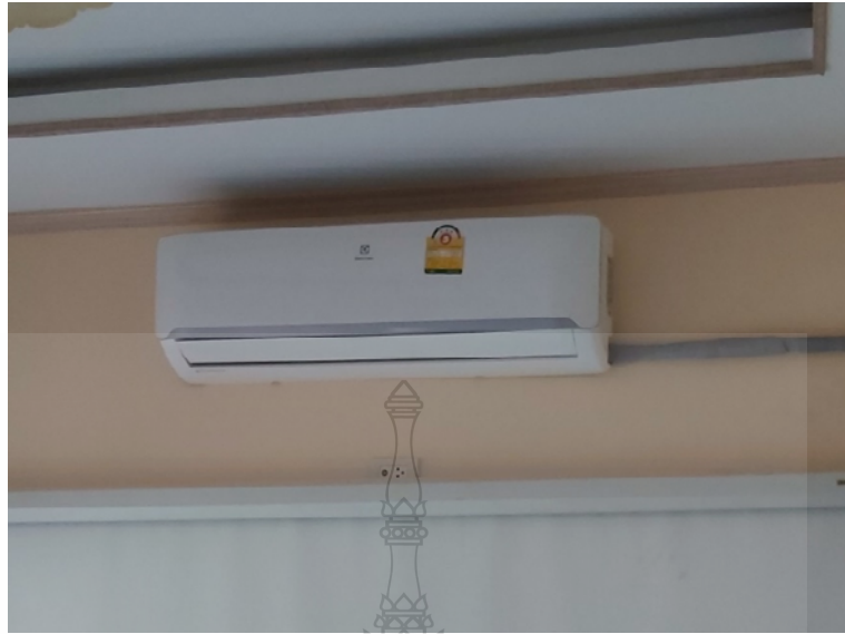
รูปที่ ก.5 Evaporator ของเครื่องปรับอากาศขนาด 18,700 Btu/hr
