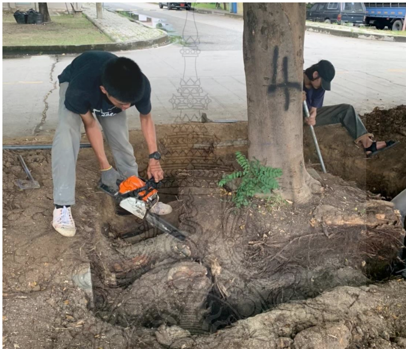
ภาพที่ 4.31 การใช้เลื่อยยนต์ตัดรากที่มีขนาดใหญ่
