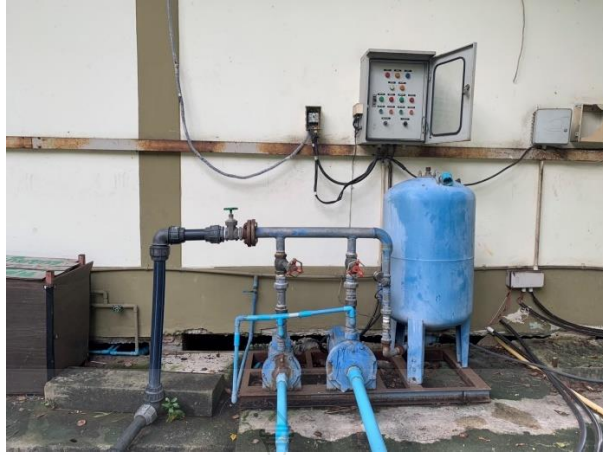
ภาพที่ 4.18 ระบบการให้น้ำอัตโนมัติของอาคารสำนักงานคณบดี คณะเทคโนโลยีการเกษตร
