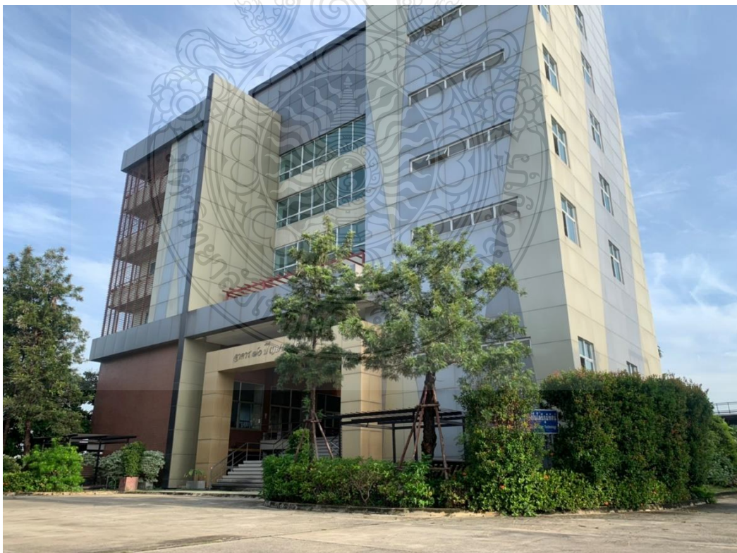
ภาพที่ 3.3 พื้นที่ฝั่งทิศใต้ อาคาร 70 ปี เกษตรปทุมธานี
