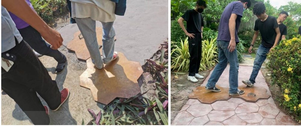
ภาพที่ 4.36 การกดแม่พิมพ์และการต่อลาย
