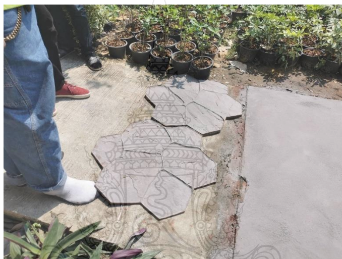
ภาพที่ 4.35 การใช้ผงลอกลายทาแม่พิมพ์และโรยบนพื้นผิวคอนกรีต
