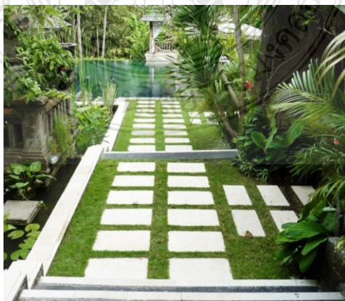
ภาพที่ 4.28 ตัวอย่างการติดตั้งแผ่นทางเท้า
