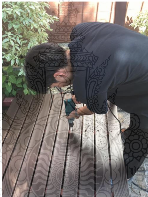
ภาพที่ 4.50 ขั้นตอนการเจาะไม้เทียมเพื่อนำร่องสกรูและเป็นที่ฝังหัวสกรูไปในเนื้อไม้เทียม
