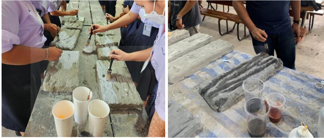
ภาพที่ 4.62 (ซ้าย) ขั้นตอนการลงสีร่องพื้นคอนกรีต (ขวา) ขั้นตอนการลงสีไม้เทียม
