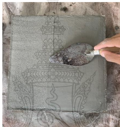
ภาพที่ 4.46 ขั้นตอนการฉาบหน้าหลังร่อนปูนซีเมนต์เขียวแล้ว
