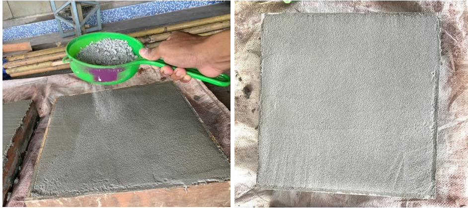
ภาพที่ 4.45 ขั้นตอนการร่อนปูนซีเมนต์เขียวในการทำแผ่นทางเท้าแบบขัดมัน
