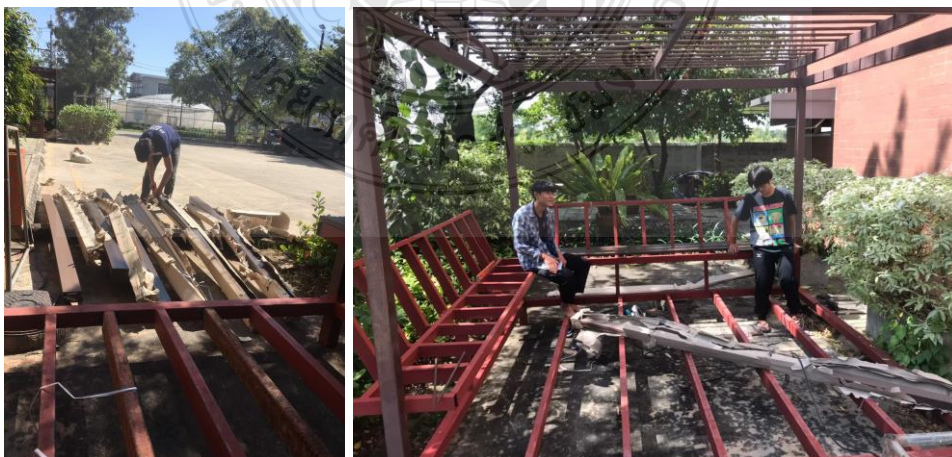
ภาพที่ 4.49 ขั้นตอนการแกะหีบห่อและการเทียบขนาดไม้เทียม
