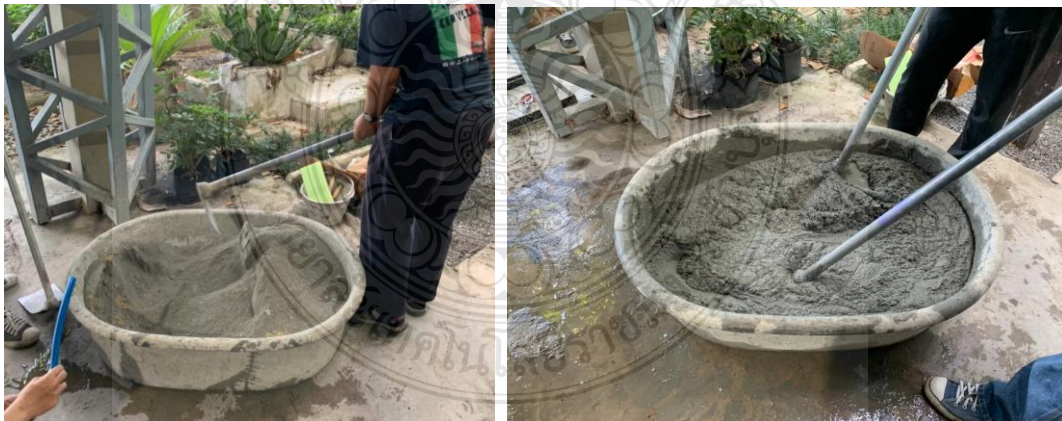
ภาพที่ 4.38 ขั้นตอนการผสมคอนกรีต
