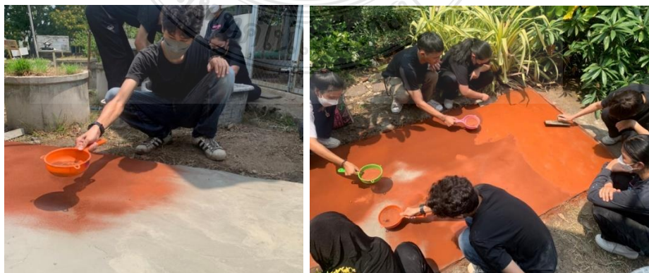
ภาพที่ 4.34 (ซ้าย) การโรยผงสีเคลือบแกร่ง (ขวา) การปาดผงสีเคลือบแกร่งให้ผสมเป็นเนื้อคอนกรีต
