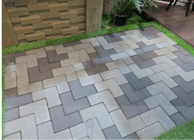
ภาพที่ 4.32 ตัวอย่างการติดตั้งพื้นผิวบล็อกคอนกรีต
