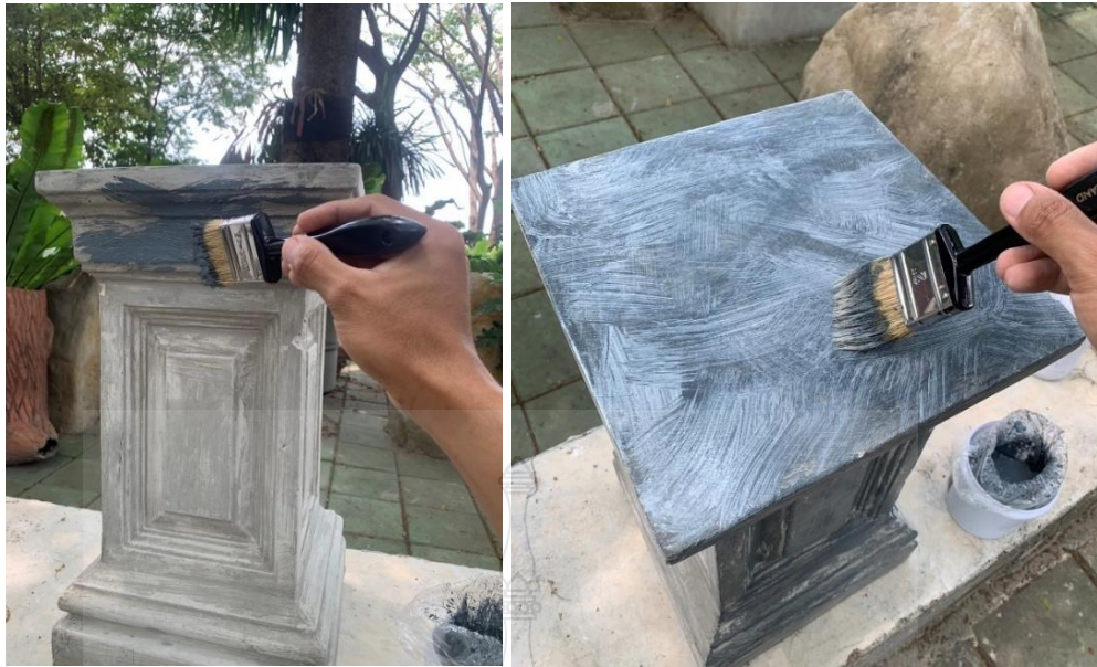
ภาพที่ 4.53 (ซ้าย) ขั้นตอนการเริ่มลงสี (ขวา) การลงสีในทิศทางที่ตัดกัน
