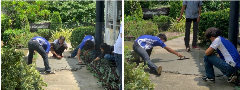
ภาพที่ 4.33 การเทและปาดคอนกรีต
