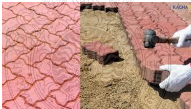
ภาพที่ 4.31 การใช้ค้อนยางทุบบล็อกคอนกรีตเพื่อให้เกิดความแน่นหนา
