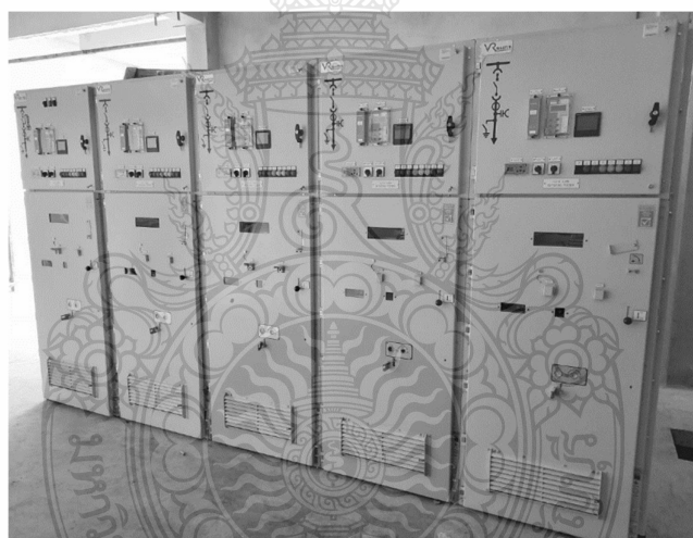
รูปที่ 2.13 อุปกรณ์ตัดตอนไฟฟ้า (Switch gear) [37]
