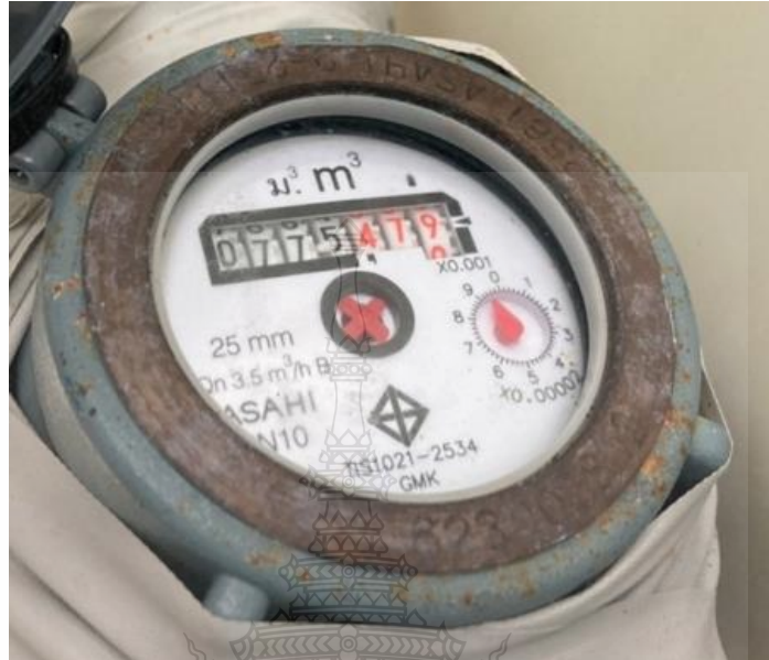
รูปที่ 4.8 แสดงมาตรวัดน้ำที่ใช้ในการควบคุมปริมาณน้ำล้นถังลดอุณหภูมิซากไก่เปื่องตันที่ทำการศึกษา
