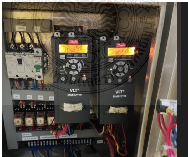
รูปที่ 4.9 แสดงการควบคุมความเร็วการหมุนใบพัดในถังลดอุณหภูมิซากไก่เปื่องตันโดย อินเวอร์เตอร์
